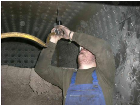
Stehbolzen ausbohren
