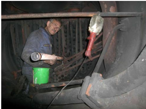
Ausbau des defekten Heizrohrs aus der 23
